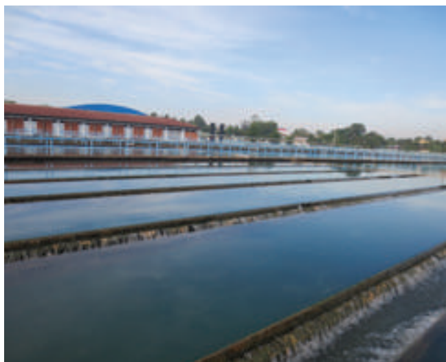
Hình: Toàn cảnh nhà máy nước Thủ Đức
